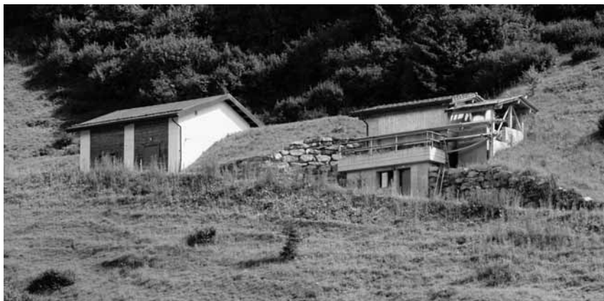
Reservoir Miraniga II links und Kleinwasserkraftwerk rechts.
