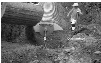
Versetzen des Reservoirs im Erdreich.
