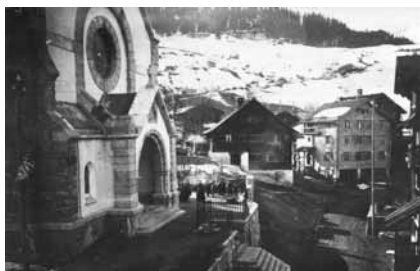
Zwischen 1905 und 1909; links Kaplaneihaus, rechts Adler. Archivfoto.
