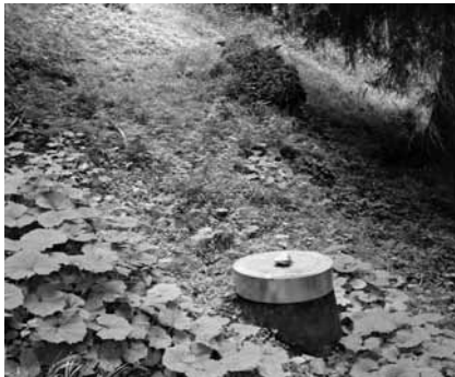
Wasserfassungen im Bebmarbrunna . 6 Fassungen, die gesamthaft 10 Quellen aufnehmen, 1595-1680 m ü. M.
