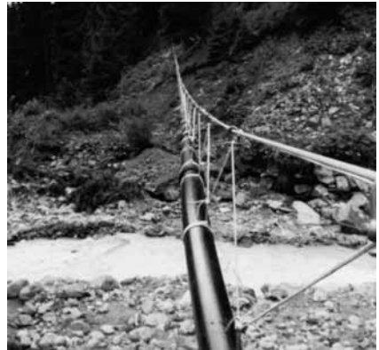
1987: An Drahtseilen aufgehängte Leitung über den Alpettlibach.
