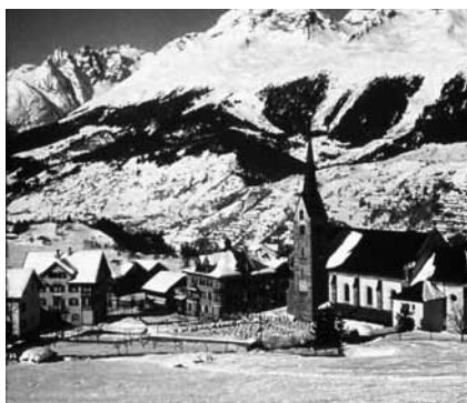
Vor 1948: Ganz l. Haus H. Sax/M. Casanova, dann Hotel Meierhof, Hotel Central mit Stall dahinter, Kirche. Dazwischen Friedhof und das Areal des späteren Restaurant Adler.
