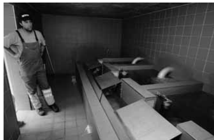
Brunnenstube Falmenboden, Inneres.
