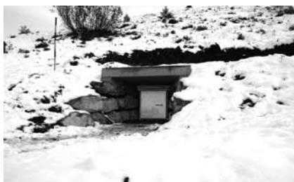
Kleinreservoir mit 5 m 3 Inhalt.
