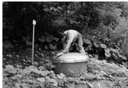
Thomas Alig putzt den Deckel eines Fassungsschachtes im Baramboda bevor er ihn öffnet. 2 Fassungen mit 4 Quellen, 1430 und 1444 m ü. M.
