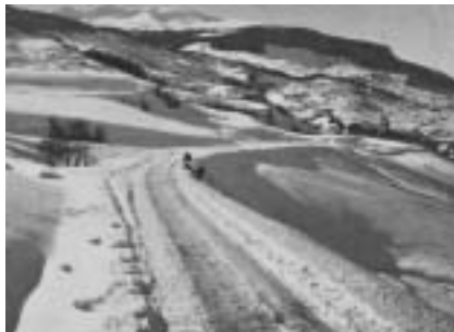
Winterstrasse beim „alten Trog“ vor Meierhof, neue Linie ab 1876, südlich davon altes „Trasse“ noch zu erkennen. Fotos Engler, Winterthur um 1910
