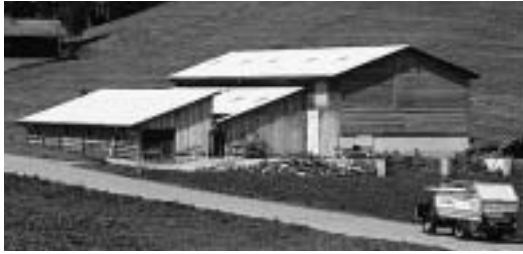
Grossstall, Laufstall Valdunga, erbaut 1999.
