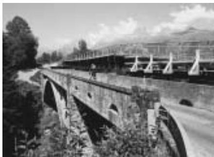
Alte Grosstobelbrücke und Notbrücke. Foto 25.7.01 EE
