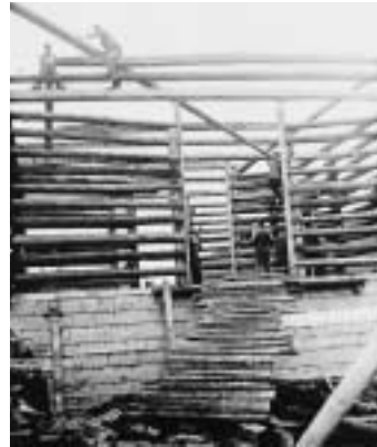
Oberstall gàpma , hier montieren eines Dachbaumes (→ Nr. 23 Querschnitt)
