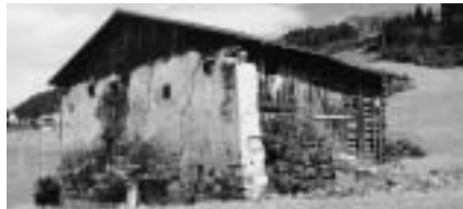
Alte Hauswand 1997. Fotos EE.
