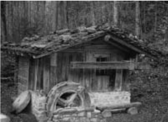
Leinsamenstampfe mit ober-schlächtigem Wasserrad aus Fuorn/Medel im Ballenberg. Foto Gschwend, Ballenberg
