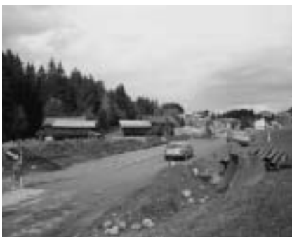
Ausbau Lorischboda 2001. Fotos EE
