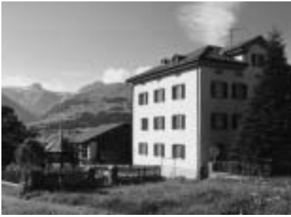
Grundstück mit Steinhauser-Haus, Garten, Gartenhaus und Stall
