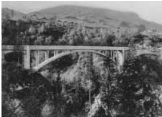
Grosstobelbrücke um 1920. Foto H. Lunte. Verstärkt, saniert 2001-03.
