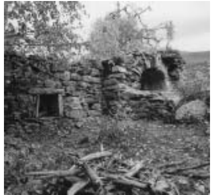
Anbau (4) mit Wandnische und Stichbogentüre zum Binnenhof
