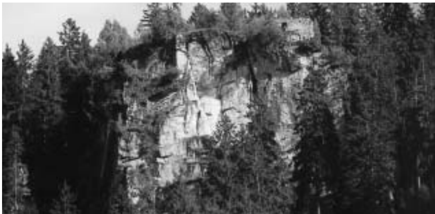
Burg (W-Trakt 2000) mit Tor von Norden, vom Tal aus gesehen. Burgfotos EE
