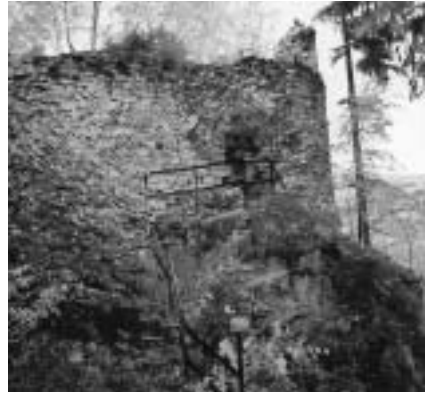
E-Trakt mit gesichertem Einstieg 1999
